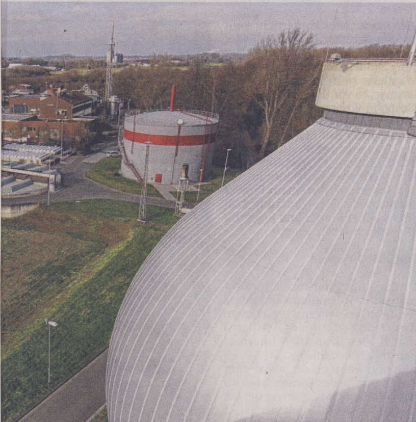
ge zur Reinigung des Abwassers gebaut werden. Rechts im Bild einer von drei Fotos: Ingo Latotzki
